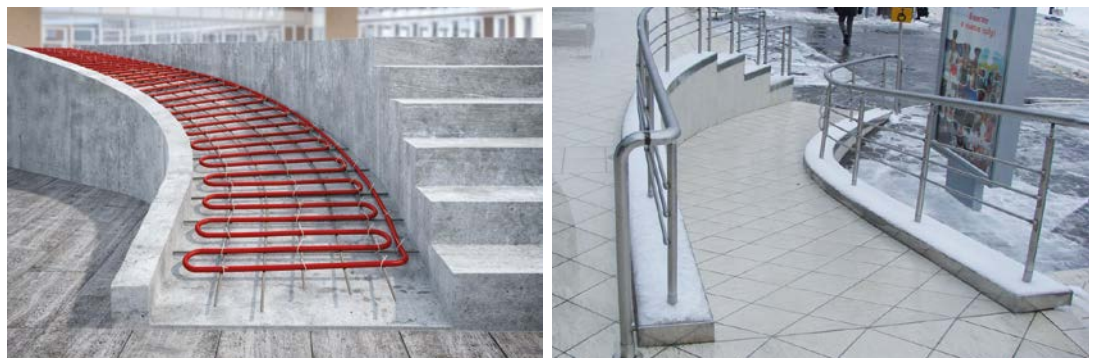
Rys. 35. Ogrzewanie powierzchni zewnętrznych KAN-therm – w trakcie i po zakończeniu robót
