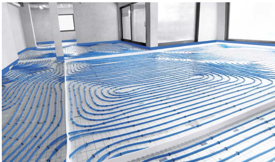
Rys. 24. Instalacja ogrzewania podłogowego wykonana w Systemie KAN-therm Tacker
