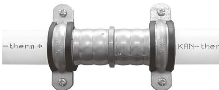
Wykonanie punktu stałego przy łączniku.
