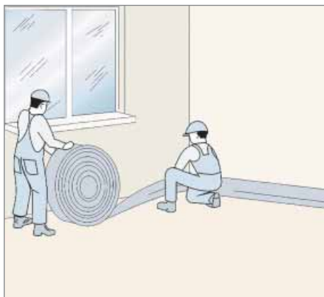
Desfaceți banda perimetrală.
