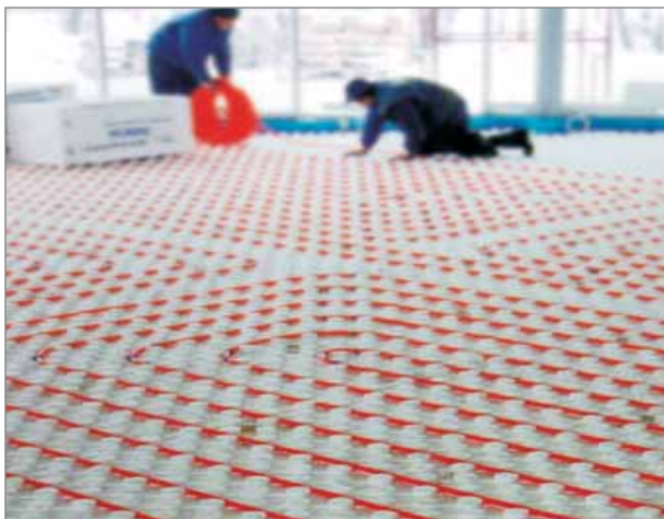
Încălzirea prin pardoseală prin metoda umedă - țevile de încălzire sunt turnate cu șapă de mortar.
