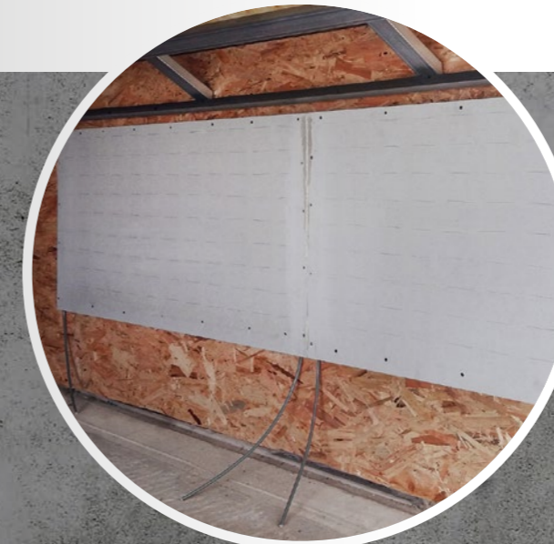
Fixarea cu șuruburi la o structură portantă din oțel sau lemn
