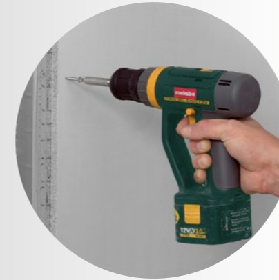
Fixarea cu șuruburi la o structură portantă din oțel sau lemn
