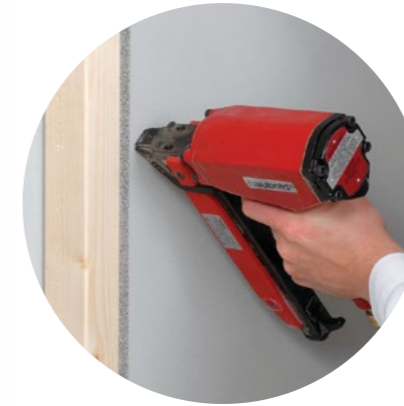
Fixarea cu cleme la o structură portantă din lemn
