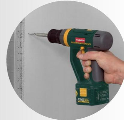
Fixarea cu șuruburi la o structură portantă din oțel sau lemn
