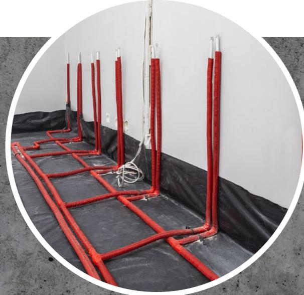
**01** Înainte de instalarea structurii portante, trebuie realizată instalația de alimentare pentru panourile de încălzire și răcire. De asemenea, este necesar să se planifice și să se amplaseze alte instalații care trebuie să fie ascunse în spatele structurii portante, de exemplu, electricitate, canalizare etc.
