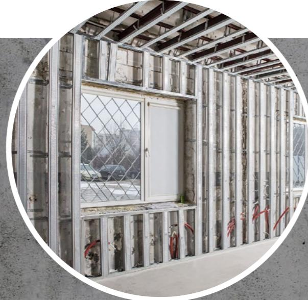
**02** După montarea tuturor instalațiilor necesare, se poate trece la asamblarea structurii de susținere pentru panouri (cadru).
