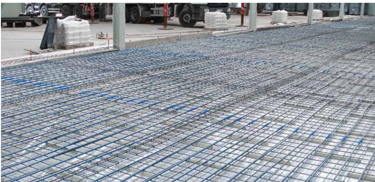
Fig. 4. Instalație de încălzire prin pardoseală într-o unitate industrială, realizată cu ajutorul țevilor bluePERT și a sistemului KAN-therm NET.
